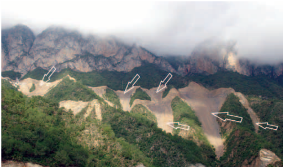
FOTO 6. Camino hacia el túnel de la obra “Acueducto II” en la ladera oriental de la Sierra de El Doctor. Las flechas señalan los abanicos de escombros que dejaron las explosiones derivadas de su construcción.
