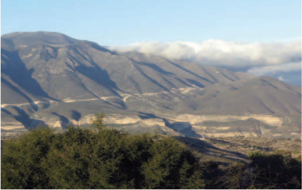
FOTO 7. Vista Sur de la sierra de El Doctor, desde la ruta Puerto del Salitre-Bellavista del Río, en donde se aprecia el camino al túnel del “Acueducto II” como una línea de color claro sobre la ladera.
